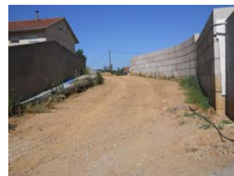
Em obras Trecho n.º 210
