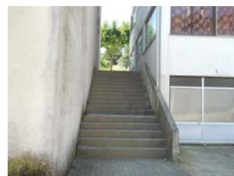
Escadas Urbanas Trecho n.º 14
