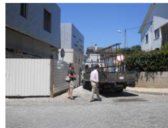
Em Obras Trecho n.º 129
