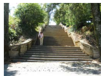
Escadas Urbanas Rua das Escadinhas
