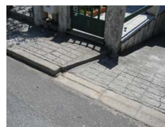
Rebaixamento para veículos mal desenhado Rua Inspector Frias
