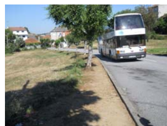
Inexistência de Passeio Rua da Cerca
