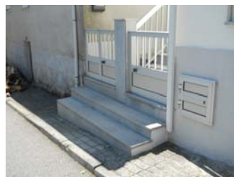
Escadas de acesso a casa Rua Mal. Olívio e Sousa
