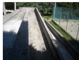
Rampa Trecho n.º 289
