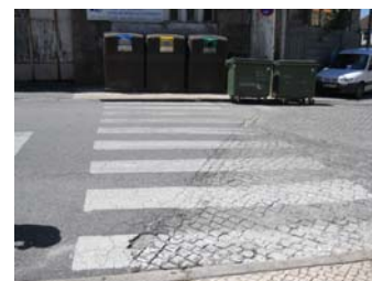
Inexistência de Rebaixamento Rua Ferreira Lapa
