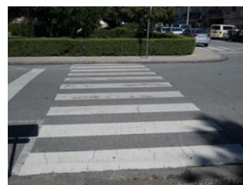
Passadeira sem rebaixamento e pavimento de encaminhamento
