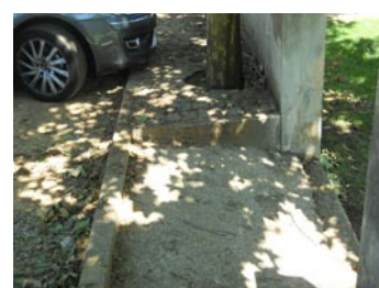
FIG. 5 - Passeio posterior no edifício
