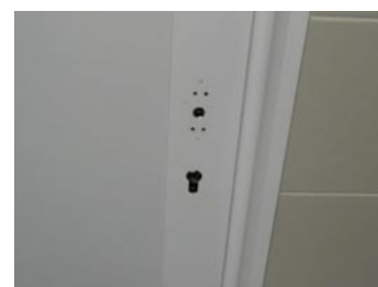
Porta de acesso a I.S. PMC encerrada nos balneários
