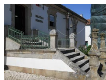
FIG. 6 - Escadas de acesso ao edifício
