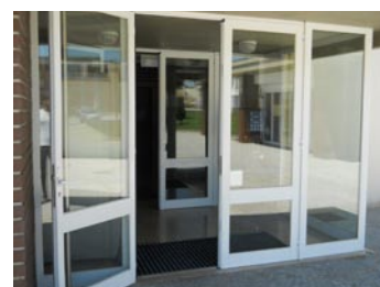
FIG. 9 - Porta de acesso ao edifício
