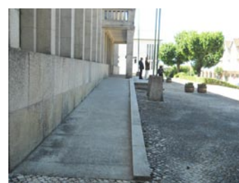
Acesso em rampa no edifício da Câmara Municipal
