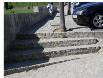
Degraus de desenho inacessível em rua com pendente acentuada
