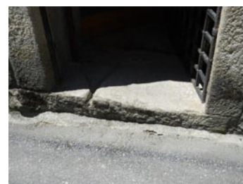
Ressalto no acesso à Casa Museu Camila Loureiro
