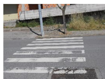
FIG. 6 - Passagem de peões não rebaixada num dos lados
