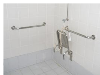
FIG. 21 - Base de duche da I.S. para PMC
