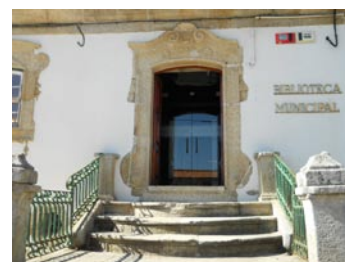
Porta de entrada do público à Biblioteca Municipal
