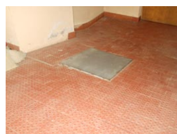
FIG. 20 - Rampa de acesso ao camarim
