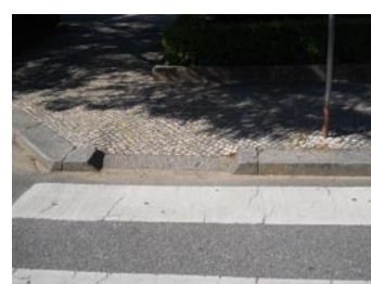
FIG. 5 - Rampa de acesso à passadeira
