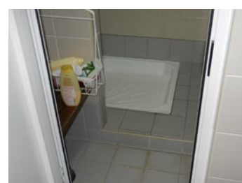
FIG. 25 - Espaços muito reduzidos com ressalto no duche
