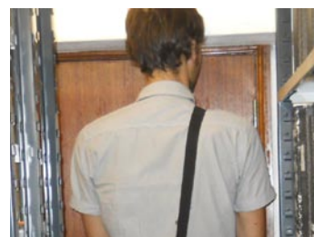
FIG. 49 - Viga saliente no piso -1
