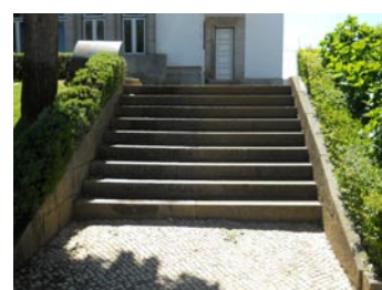
FIG. 5 - Escada de acesso à praça Paulo VI
