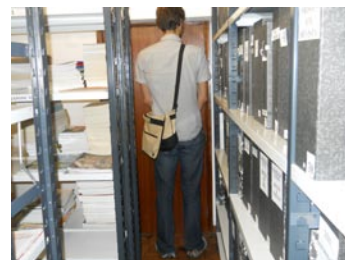
FIG. 17 - Porta com vão insuficiente e viga saliente
