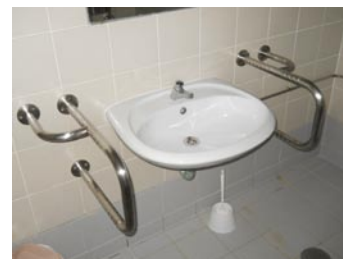
Lavatório com barras de apoio na Piscina Municipal
