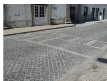
FIG. 5 - Passadeira junto ao edifício
