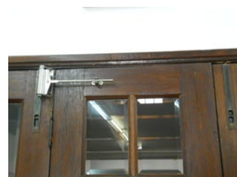
FIG. 21 - Detalhe da mola da porta tripla
