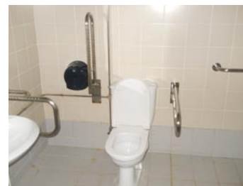
Instalações adaptadas nas Piscinas
