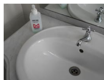
Torneiras inacessíveis existentes na maioria dos edifícios
