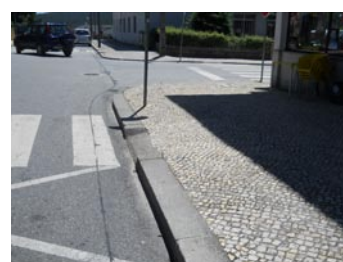
FIG. 5 - Rampa de acesso à passadeira
