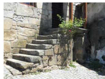
Escadas exteriores de acesso ao piso 1 do Museu Camila Loureiro
