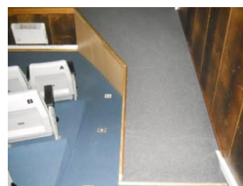
FIG. 16 - Rampa de acesso ao palco
