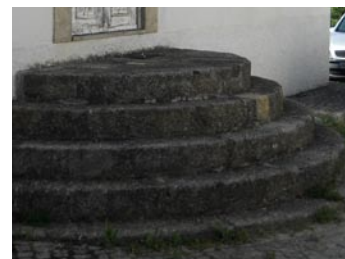
FIG. 8 - Escadas de acesso ao edifício
