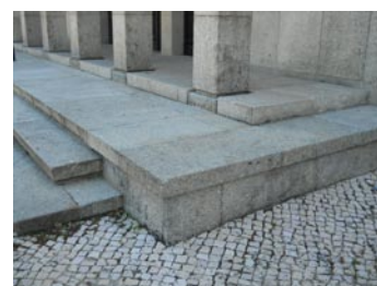
Degraus de acesso ao edifício da Câmara Municipal
