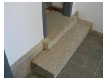
Degraus no interior da Escola
