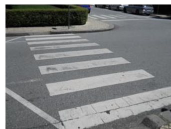
FIG. 4 - Passadeira próxima ao edifício
