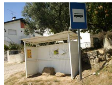
Abrigo mal localizado, Estrada Nacional 229
