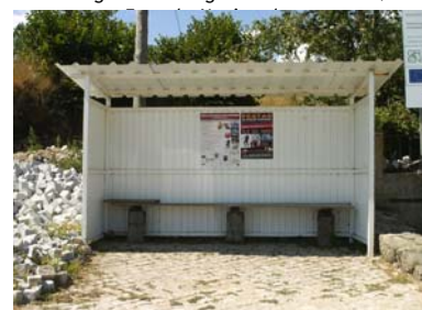
Abrigo com banco longitudinal sem espaço livre, Estrada Municipal
