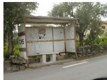
Paragem sem acessos pedonais Estrada Municipal 329
