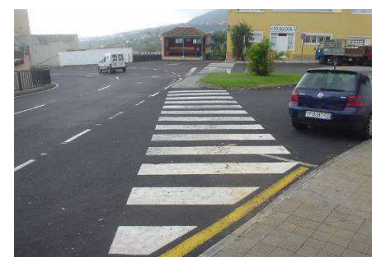
Exemplo de passadeira diagonal correctamente sinalizada
