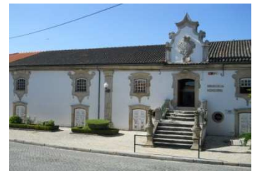
A Biblioteca Municipal é um edifício completamente inacessível a pessoas com mobilidade condicionada.
