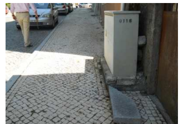
Na Rua 25 de Abril uma caixa de eletricidade está colocada junto à fachada de uma casa não respeitando o espaço do canal livre de circulação para invisuais e pessoas que se desloquem em cadeira de rodas.
