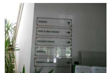
Os painéis com os serviços que funcionam na Câmara Municipal têm uma textura pouco recomendada pois reflete a luz e torna pouco acessível a sua leitura.
