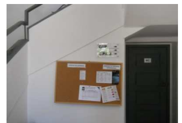
Painel informativo pouco acessível no edifício da antiga Escola devido ao tamanho da letra da maior parte dos documentos afixados ser demasiado reduzido.
