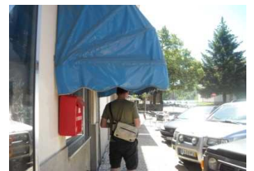
Toldo na Rua José de Frias Barbosa, a uma altura inferior a 2,40m é considerado mal desenhado e corre o risco de não ser detetado pelos peões.
